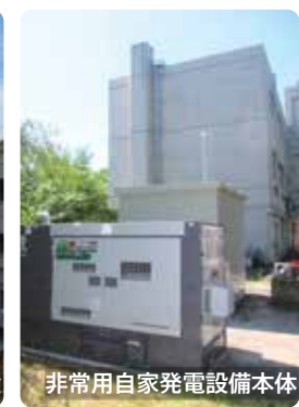
本館北側スペースへ設置
