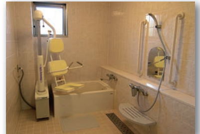
リフトを備えた個別浴槽
